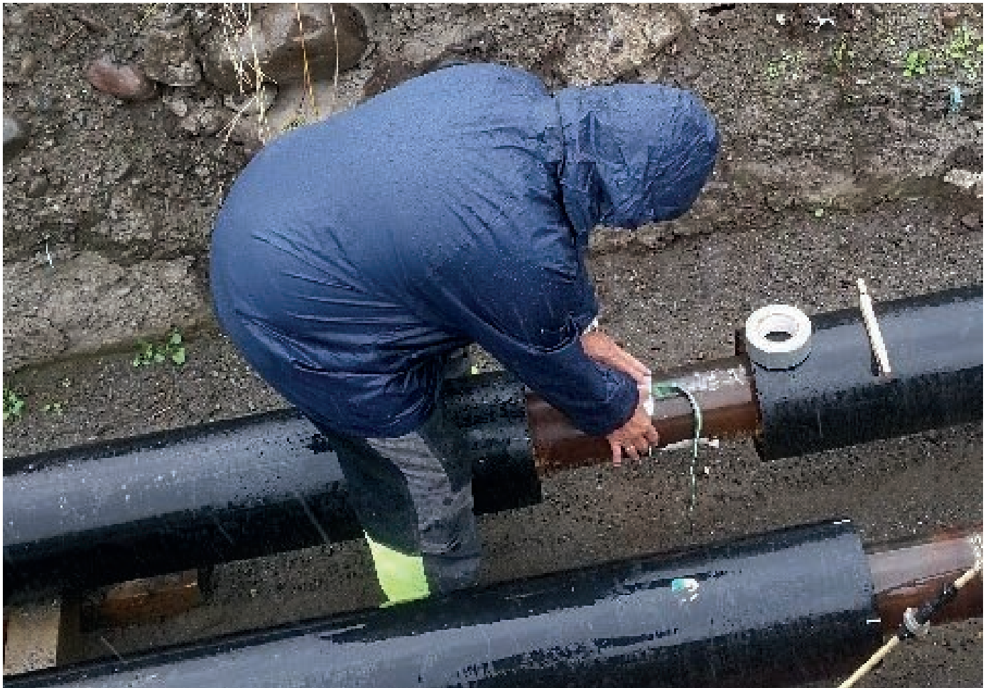
BILDE: EN TYPISK FJERNVARMEJOPP
