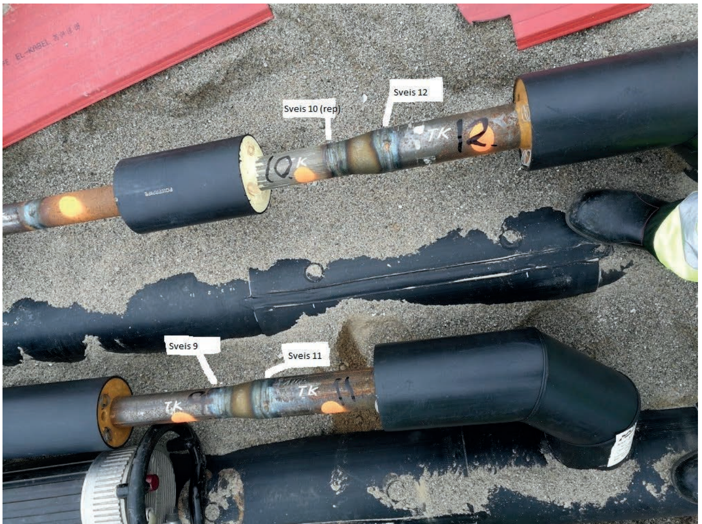
BILDE: EN TYPISK FJERNVARMEJOPP
