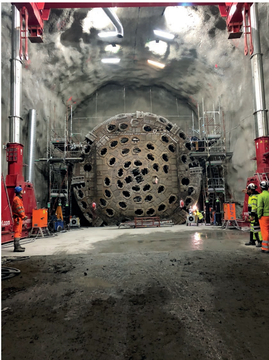
BILDE: DEMONTERING AV ETT FJELLBOR. JEG VAR DER FOR Å TA PENETRANT AV LØFTEØRENE SOM BLIR SVEISET PÅ NÅR BORET SKAL LØFTES UT. Foto:LKJ
